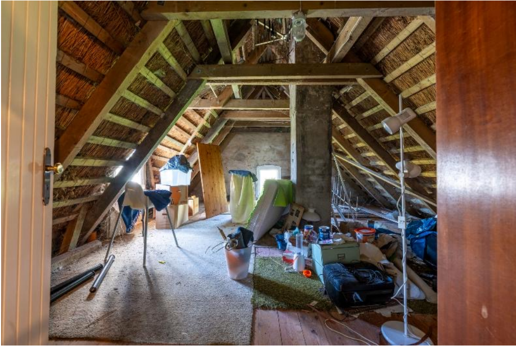
Als Speicher genutzter Teil des Dachgeschosses
